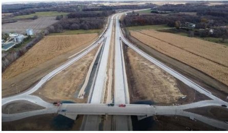
CSAH 5 View East
