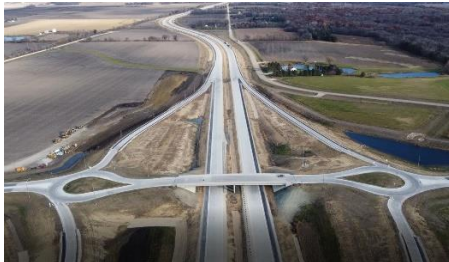
CSAH 3 View East
