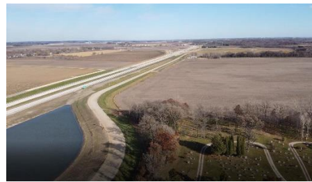
CSAH 1 View East
