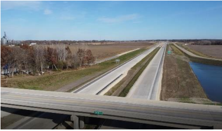
CSAH 1 View East
