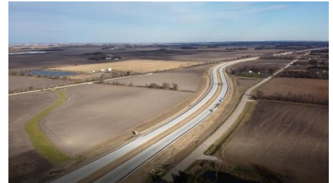
CSAH 3 View East
