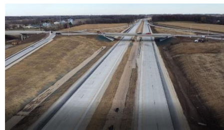
CSAH 5 View East
