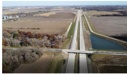
CSAH 1 View East
