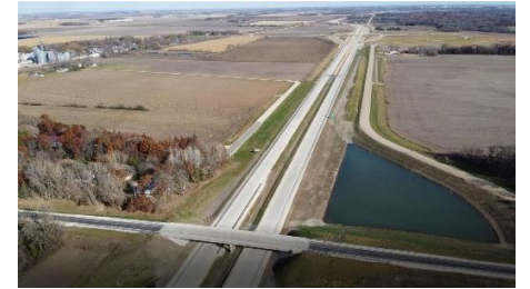
CSAH 1 View East
